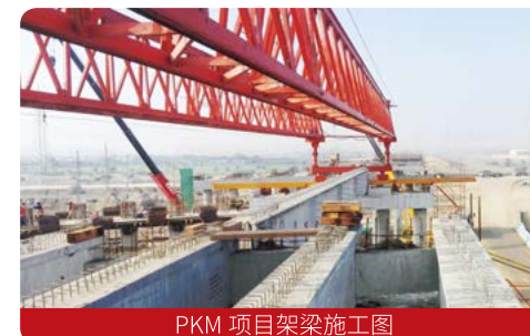
PKM 项目架梁施工图
